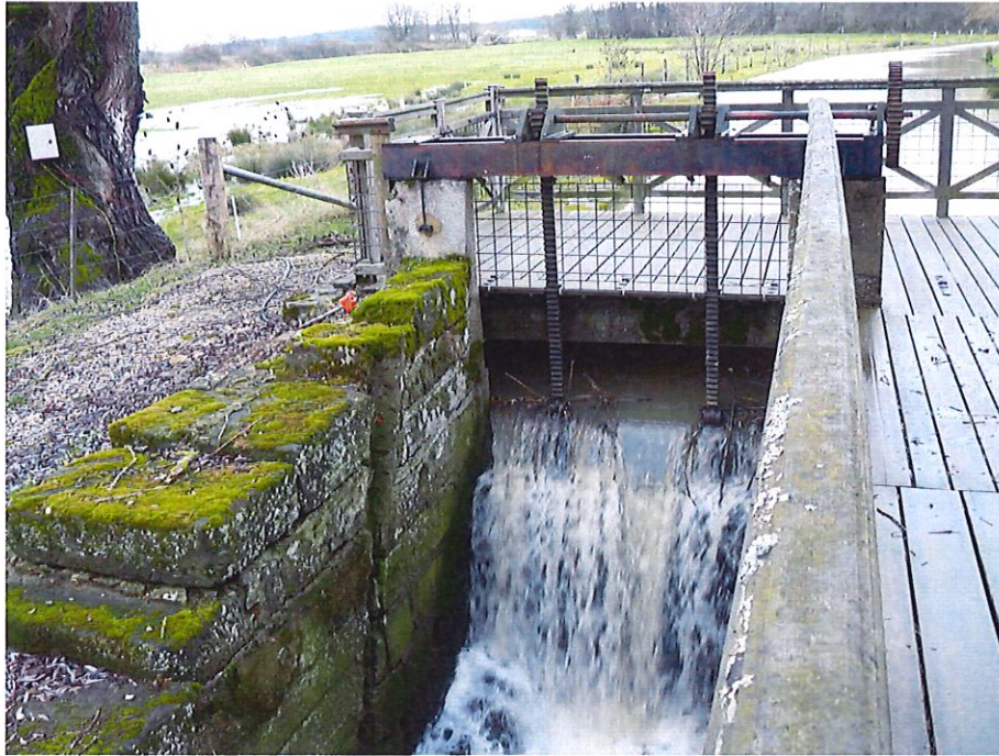
L'installation de production d'électricité
